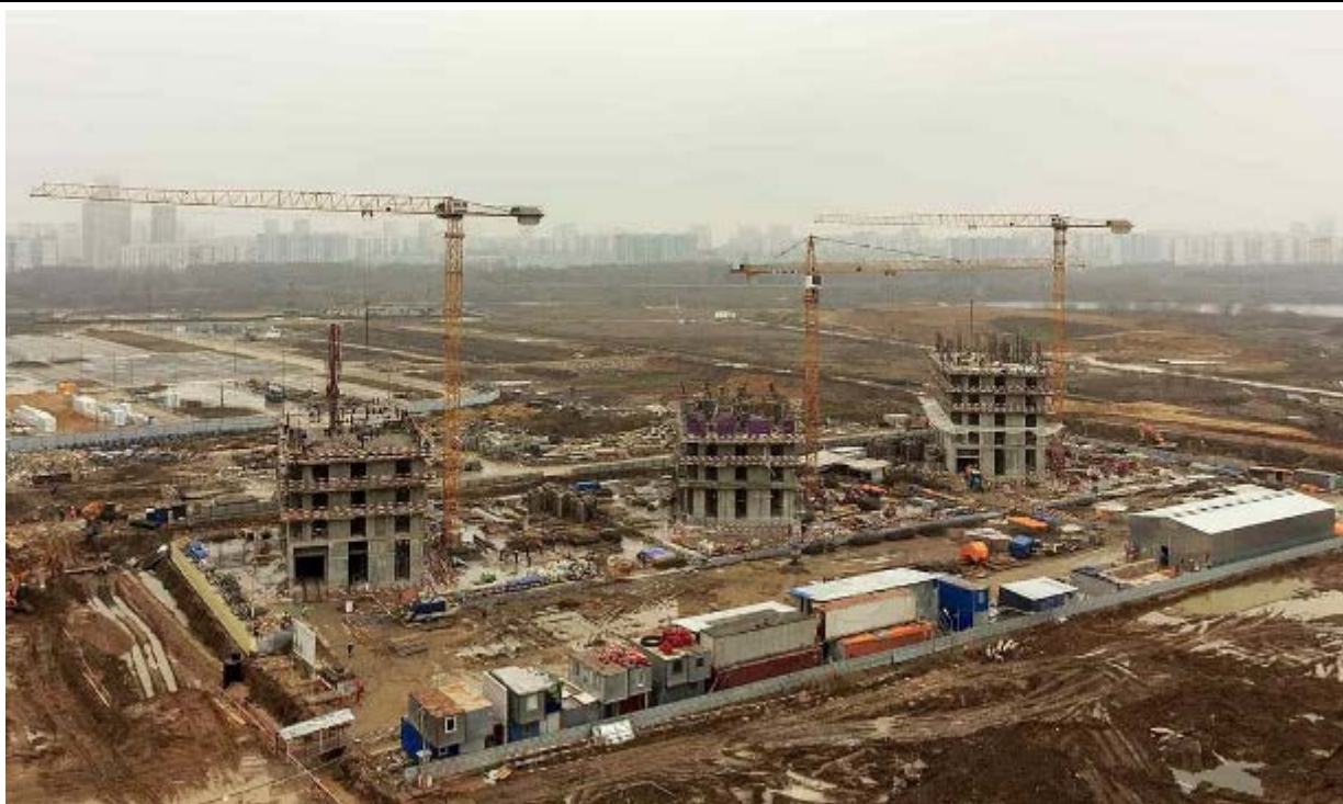
Внешний вид МЖД Корпус 6
