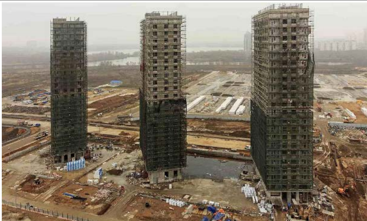
Внешний вид МЖД Корпус 4
