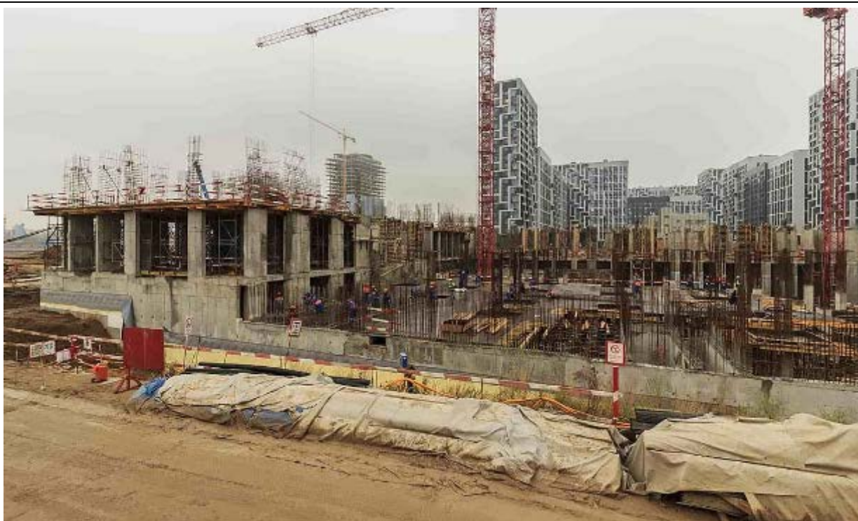
Внешний вид МЖД Корпус 5
