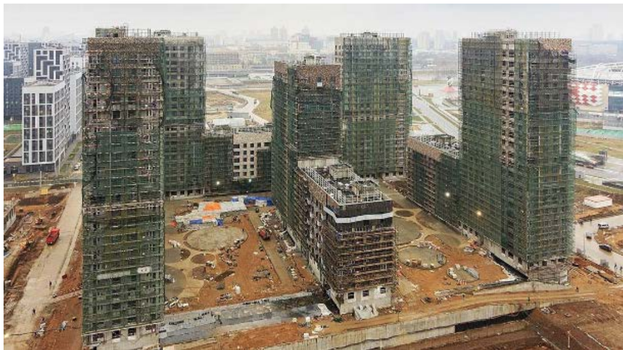
Внешний вид МЖД Корпус 3
