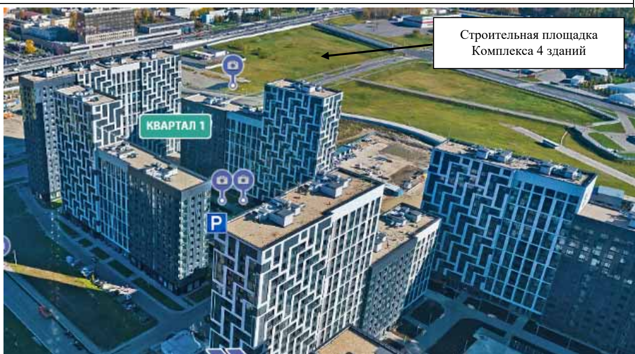
Внешний вид строительной площадки Комплекс 4 зданий (корпусов) с нежилыми помещениями для временного проживания
