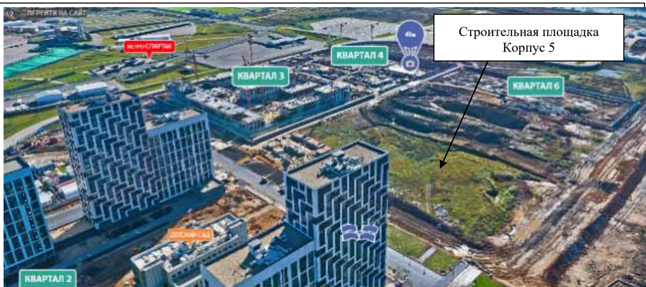
Внешний вид МЖД Корпус 3, Корпус 4, Корпус 6, строительная площадка Корпус 5
