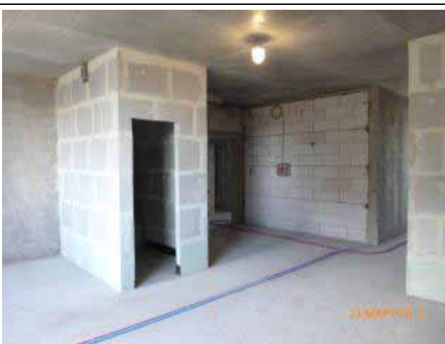
Внутренне состояние (Корпус 2)
